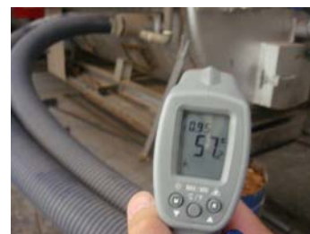
鍋爐壁溫度量測
